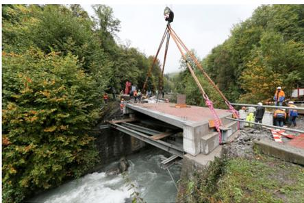
Abb. 185 | Die komplette Balsaholzbrücke wird in Bex (VD) aufgestellt.
